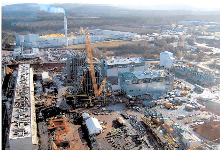
Avril 2009 : chantier sur la centrale Cycle Combiné Gaz Emile Huchet.
