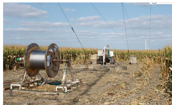
Tirage de câbles
