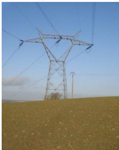
Vue du pylône 402
