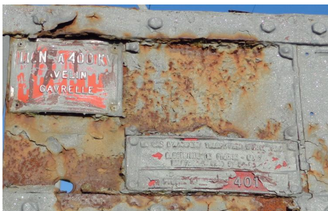
Vue de la plaque du pylône 401
