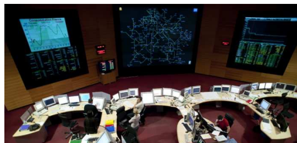
L'équilibre et la fréquence du réseau seront gérés en temps réel au Centre National d'Exploitation du Système (CNES) de RTE, en lien avec les autres gestionnaires de réseaux européen (Crédit photo : Stéphane Herbert).
