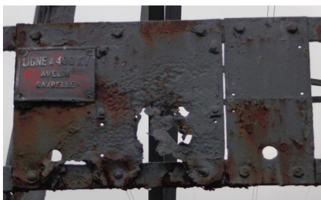
Vue du pylône 389
