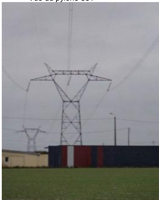
Vue du pylône 381
