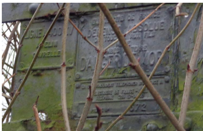
Vue du pylône 372
