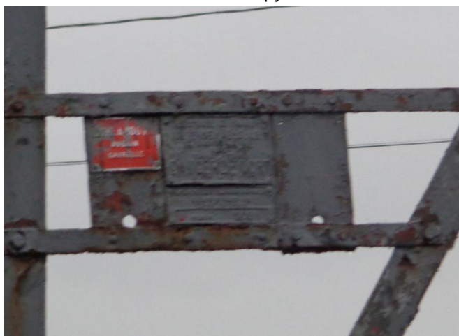
Vue du pylône 368
