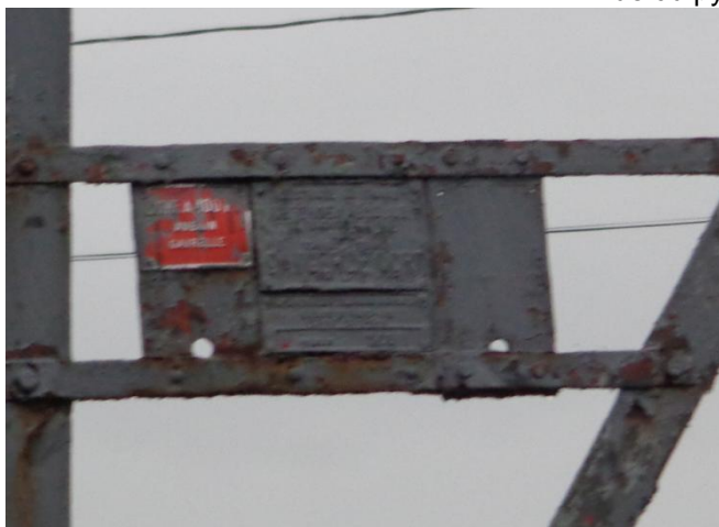
Vue du pylône 368
