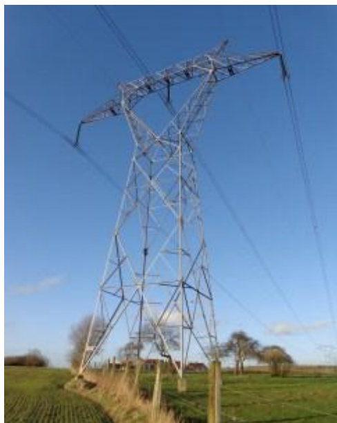
Vue du pylône 399
